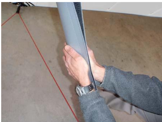
Figure 5-5 : Mise en place des profilages
