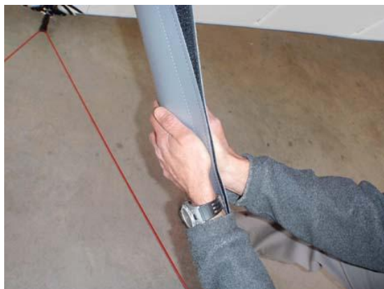
Figure 5-5 : Mise en place des profilages
